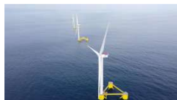
WindFloat Atlantic (25MW、2020年運開)
